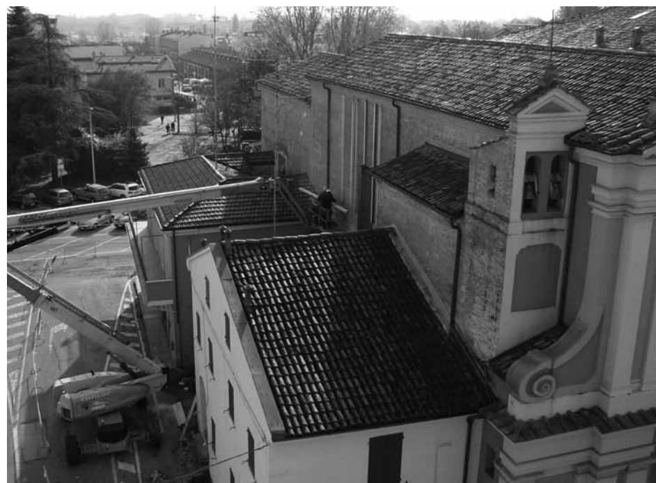
I lavori di messa in sicurezza della Chiesa della Cintura (Novembre 2012)
